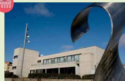
Piscina Climatizada Almeriz
